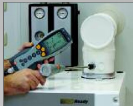
Verkleidung montieren und Verbrennungswerte kontrollieren
