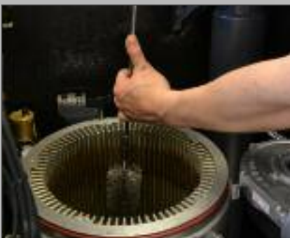
Wärmetauscher mit Bürste reinigen
