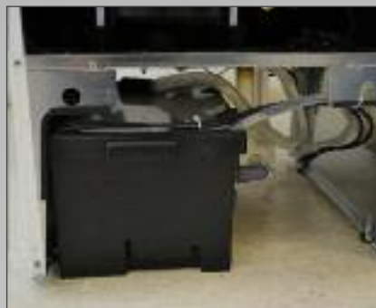
Siphon, Neutralisation und Kondensatpumpe reinigen
